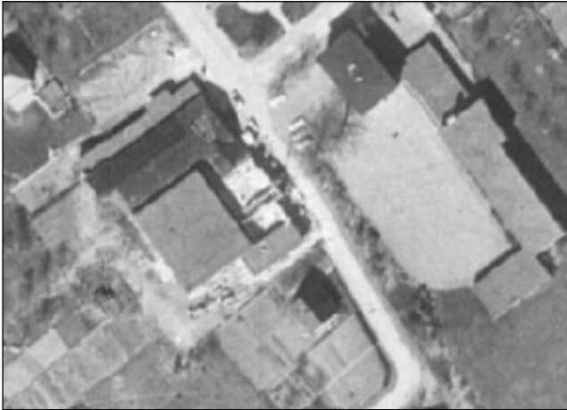
Luftbild 1971. Die große Halle ist bereits errichtet, der Gebäudeteil entlang der Hubertusstraße noch im Bau
