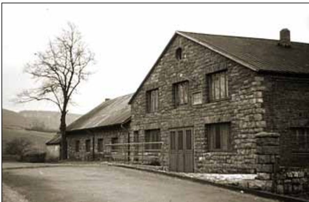
Außenansicht 1955 entlang der Hubertusstraße. Der hintere Bereich wurde später abgerissen
