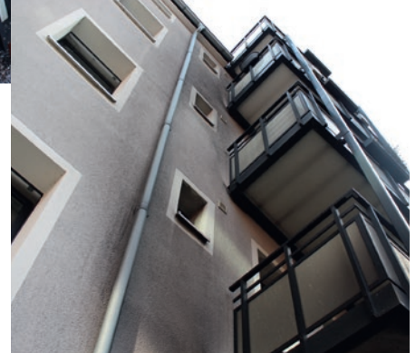
Das sieht nicht gut aus: Der Balkon ist zerstört und die Fassade durch Ruß verschmutzt.
