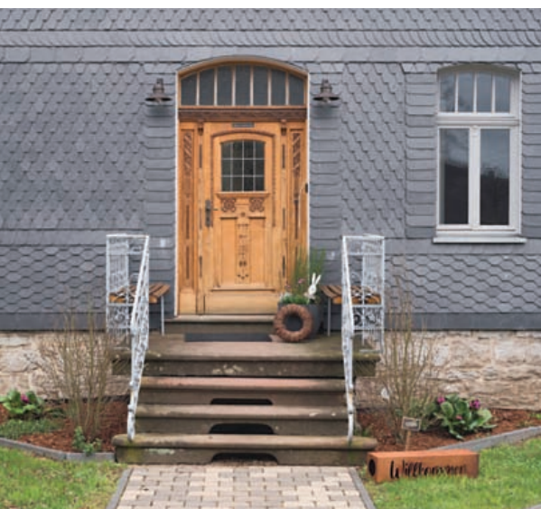
8 Eingangstür, Westfassade. Foto 2024.
