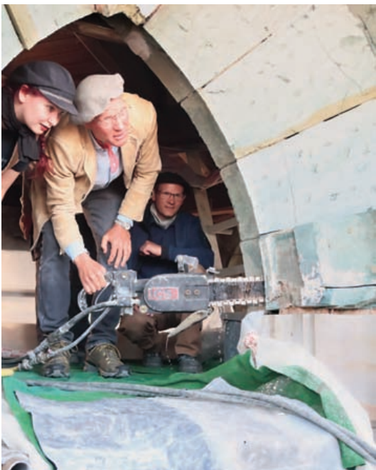
5 Altdombaumeister Jürgen Prigl (Mitte) mit Bauhüttenmeister Markus Schulze (rechts) beim feierlichen Rückbau des letzten Steins am Nordturm mit Hilfe einer Diamantschwertsäge. Foto 2023.
