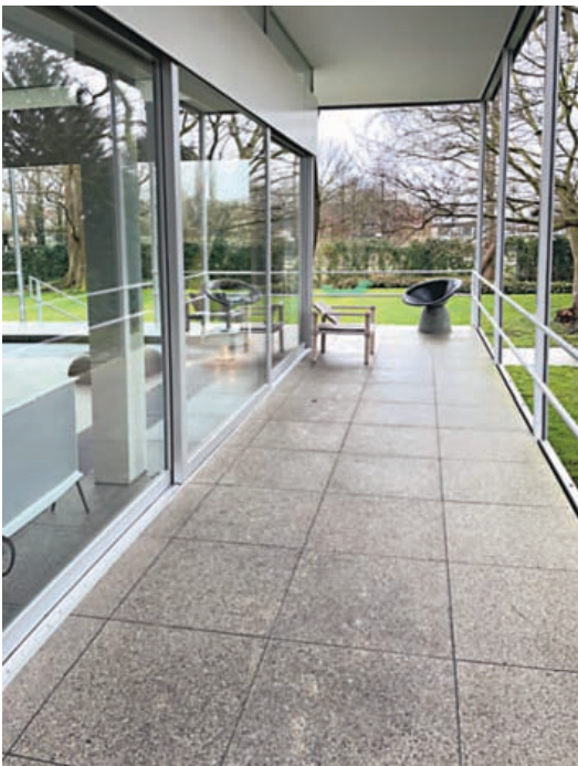
7 Instandgesetzte Aluminium-Fenster. Foto 2024.
