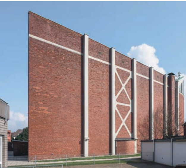
3 Ansicht von Westen auf die Stahlbeton-Stützen. Foto 2024.
