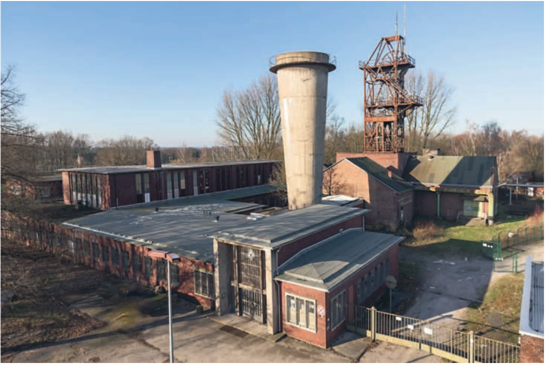
1 Zeche General Blumenthal / Schacht 7 in Recklinghausen. Foto 2024.
