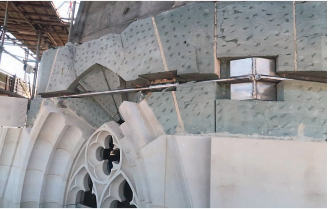
3 Die äußere Steinschicht mit Obernkirchner Sandstein, darüber der bereits rückgebaute „Grünsandstein“ mit einem eingezogenen Ringanker aus Edelstahl. Foto 2023.
