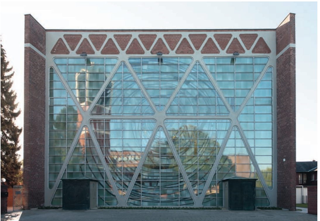
4 Nordseite mit Meistermann-Fenster. Foto 2018.
