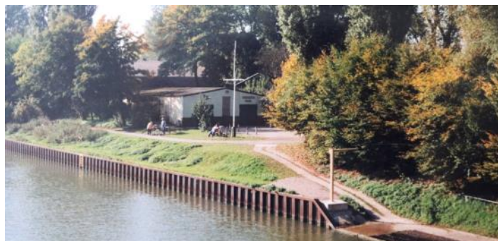
Bootshalle vor dem Kanalausbau
