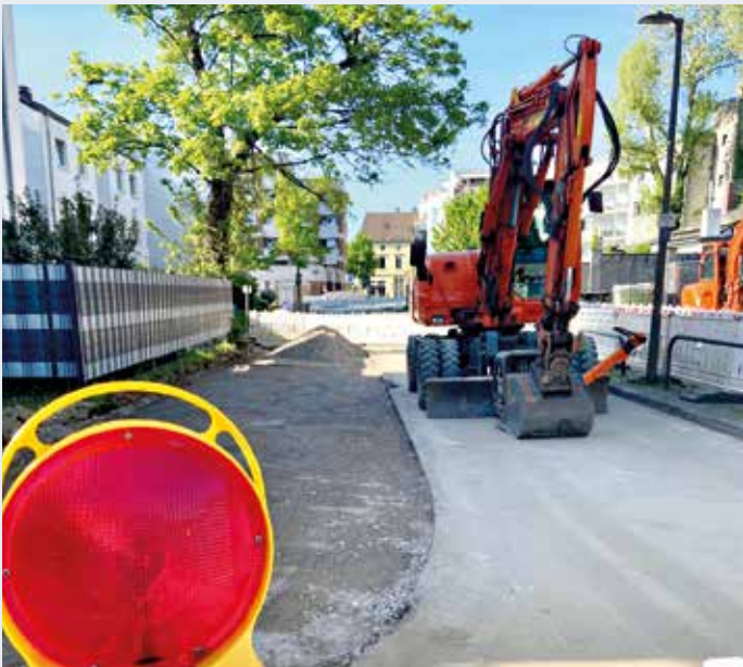
Der Umbau des Hofstadtweges läuft auf Hochtouren. Foto: Nolte
