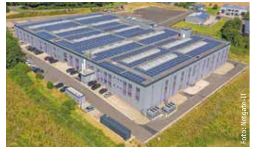
Schon seit 10 Jahren bedecken Solarzellen das Dach der Terra-Cloud in Hüllhorst
