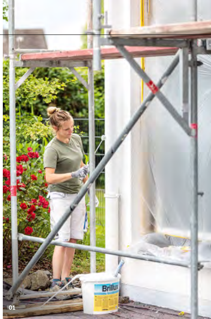
01 — Genießt die Arbeit auf der Baustelle: Für Vanessa Becher kam ein Job im Büro nicht infrage
