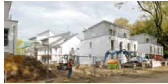
Miteinander wohnen: Doppelhäuser und Häuser mit mehreren Wohnungen entstehen in Röhlinghausen.
