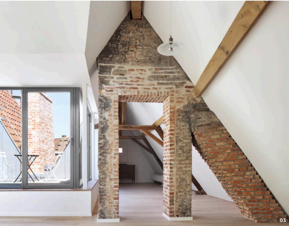
03 — Ein gemauerter Schornstein, die Holzbalken und der Dachstuhl erinnern an die Vergangenheit. Die alten Holzfenster wurden rekonstruiert. Alle neu eingebauten Fenster, die Treppen und Balkone bestehen aus Stahl
