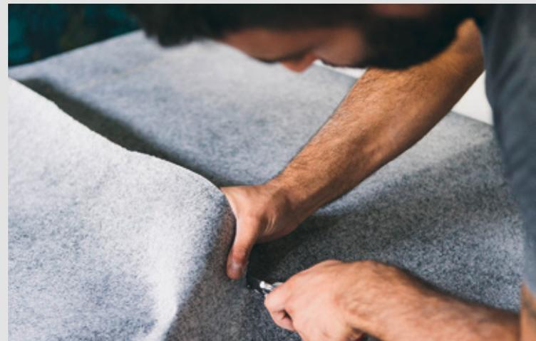
Eine Wand wird zum Whiteboard: Zunächst wurde das Magnetvlies zugeschnitten und auf die glatt geschliffene Oberfläche geklebt. Dann folgten Abporen, Grundieren, Zwischenschliff, Zwischenbeschichtung, ein neuerlicher Zwischenschliff und die abschließende Whiteboard-Beschichtung.
