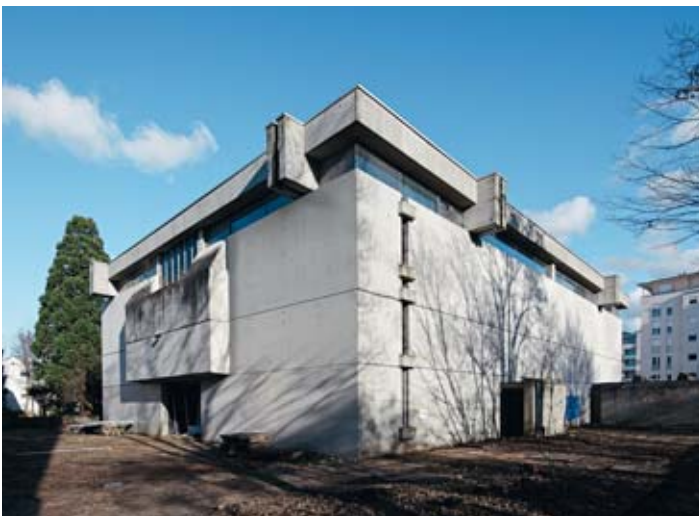
Die 1965 fertiggestellte Kirche St. Elisabeth war von dem Karlsruher Architekten Rainer Disse (1928–2008) als Monument der „Einfachheit und Würde“ konzipiert worden. Seit 2005 stand sie unter Denkmalschutz.
