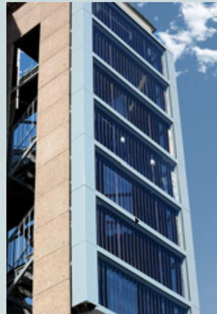
Pilotinstallation eines teiltransparenten thermischen Fassadenkollektors in Slowenien: Der Kollektor blockt hohe Sonnenstände und vermindert dadurch den Kühlbedarf. Die Durchsicht nach draußen ist davon nicht beeinträchtigt.
