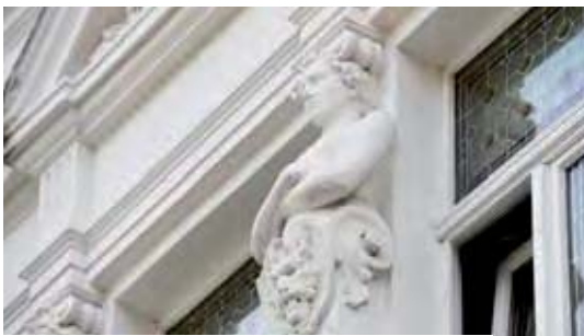
Auch Stuckateurarbeiten werden mit Akribie und Liebe zum Detail ausgeführt.
