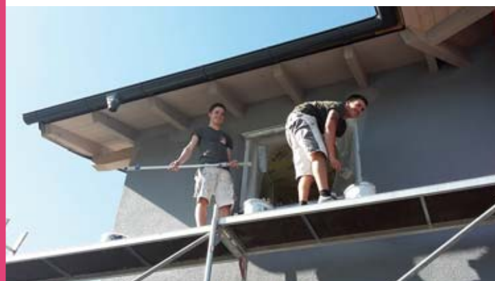
Eine Frage der Firmenehre: Der ausführende Betrieb ihrer neuen Fassade war die Maler Werkstatt Markus Mayer selbst. In vier Wochen war sie fertig.
