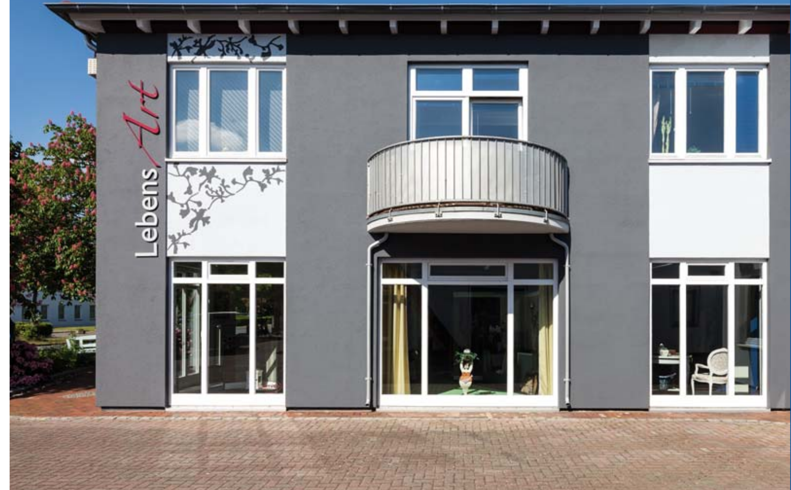
Gestaltung und Farbkonzept der neuen Fassade sollen dazu beitragen, dass sich Kunden der Firma Buschmann in guten Händen wissen.
