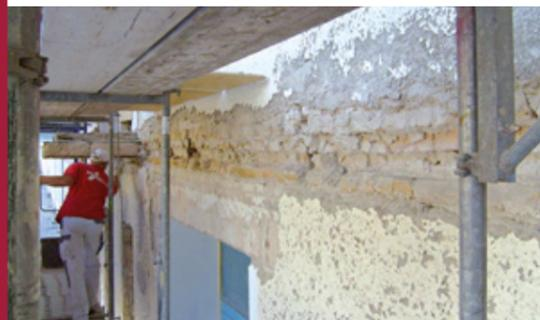
Bei der Einbindung der zuvor gemauerten Balkone musste darauf geachtet werden, dass keine Wärmebrücken entstehen.
