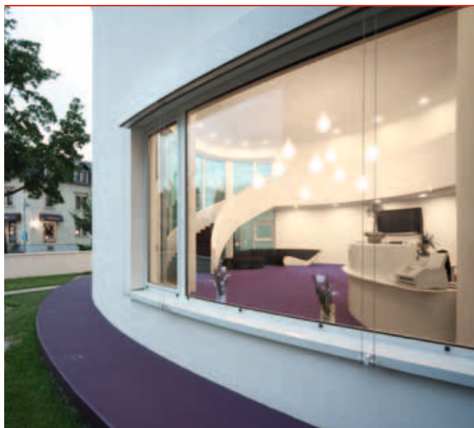
Mit speziell angefertigten, radial geformten Brillux Qju Dämmplatten und aufwendiger Verarbeitung des weiteren Fassadenaufbaus gelang eine homogene, ästhetisch hochwertige Lösung.
