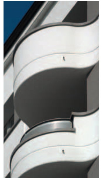
Die neue Thermohülle an diesem 60er-Jahre Hochhaus ermöglichte eine energetische und gestalterische Aufwertung – aus harten Kanten wurden fließende Gebäudesilhouetten.
