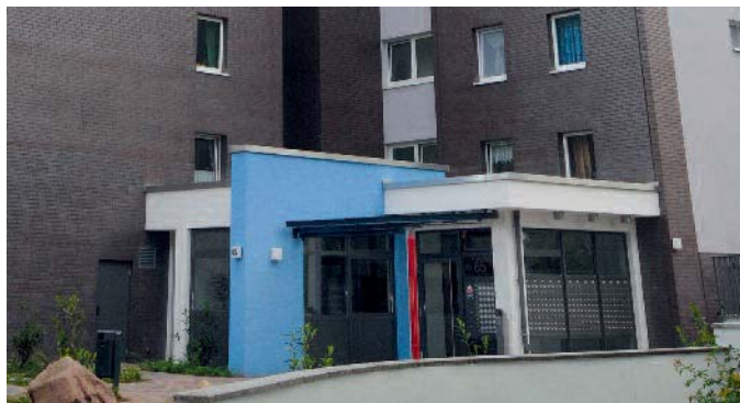
Großes Haus ganz überschaubar: Die neue Fassadengestaltung gibt dem Hamburger Hochhaus eine neue, angenehme Dimensionierung und schafft interessante Perspektiven.
