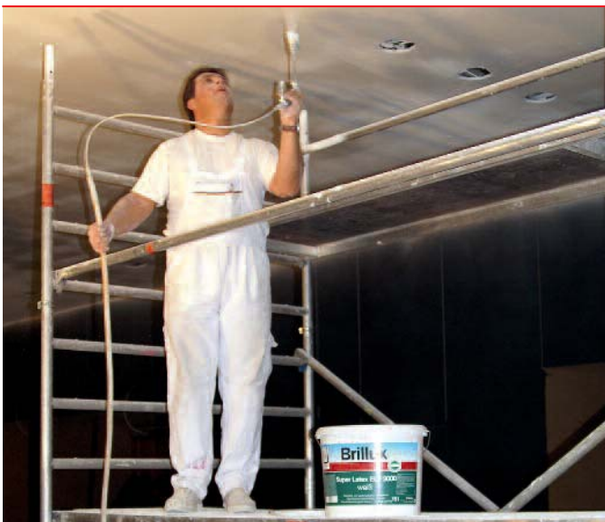
Unter der Kuppel der Frankfurter Festhalle wächst die Stahlkonstruktion in die Höhe. Geplant wurde das Standskelett in Trockenbauweise. Rund 8.800 Quadratmeter Wand- und Deckenfläche beschichtete der Frankfurter Malerbetrieb Kerger in drei Wochen Dauereinsatz. (Fotos: Brillux)
