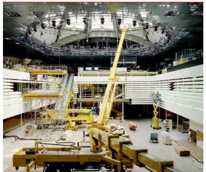
Unter der Kuppel der Frankfurter Festhalle wächst die Stahlkonstruktion in die Höhe. Geplant wurde das Standskelett in Trockenbauweise. Rund 8.800 Quadratmeter Wand- und Deckenfläche beschichtete der Frankfurter Malerbetrieb Kerger in drei Wochen Dauereinsatz. (Fotos: Brillux)
