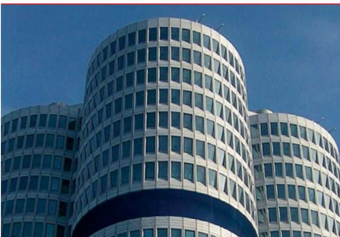
*Links: Deutlich zu erkennen sind die neuen lichtdurchlässigeren Fensterscheiben. Die Verkleidung des Gebäudes aus Aluminiumpaneelen wurden mit Seifenwasser gereinigt und anschließend auf Hochglanz poliert.*
