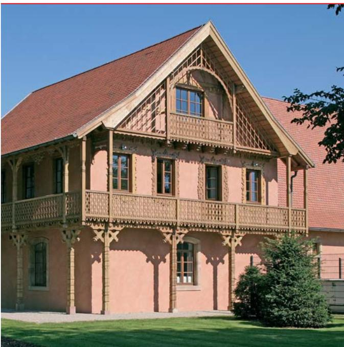
Abgetragen und neu errichtet: Die aus 1853 stammende Remise Nord dient heute als Restaurierungswerkstätte. Die Holzkonstruktion konnte mit Originalbauteilen rekonstruiert werden.
