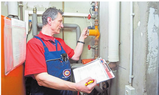
Mit einer Heizungswartung versetzt der SHK-Fachmann die Anlage wieder in einen optimalen Betriebszustand.
