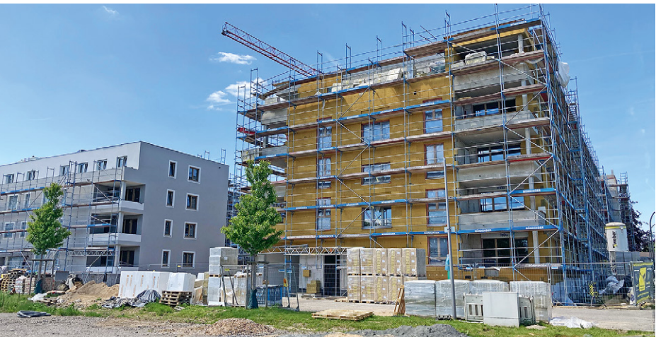
Neubau ist keine entscheidende Lösung: Baustelle im Bochumer Neubaugebiet Ostpark
