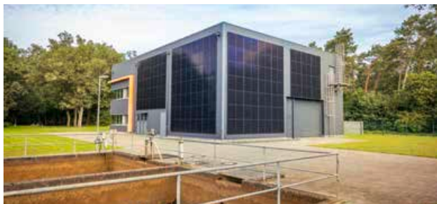
Fast autark: Die Solarmodule auf der Rückseite der Filterhalle produzieren den Großteil des Stroms für Pumpen und Kompressoren. Auf dem Bild rechts ist Markus Frenk in den Schacht eines Trinkwasserbrunnens hinabgestiegen und kontrolliert das Ventil.
