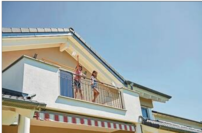
Draußen Sonne und innen kühl – mit einem gut gedämmten Dach geht das. Foto: DJD/puren
