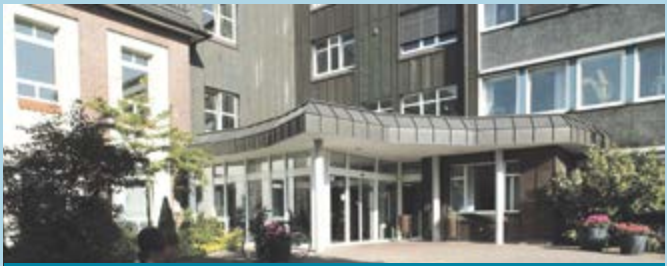
St. Antonius-Krankenhaus Kirchhellen Gartenstraße 17 • 46244 Bottrop-Kirchhellen T 02045 891-0
