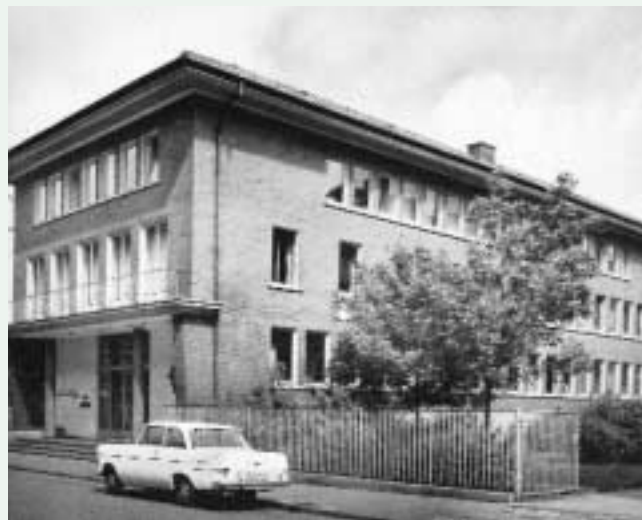
... und der fertig gestellte Neubau.
