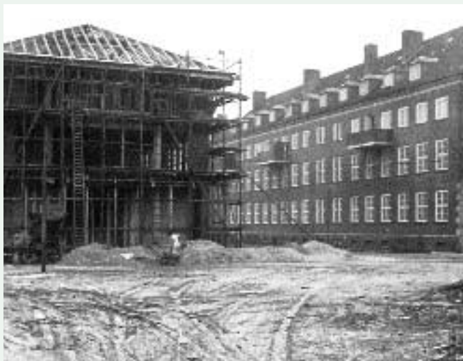
Die Baustelle in der Brockhoffstraße 1954 ...
