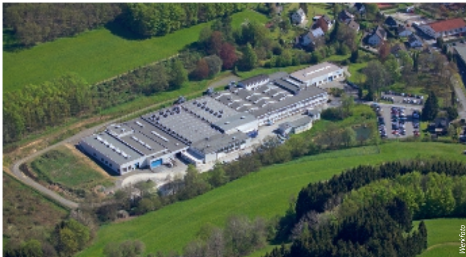
Die in Hilchenbach ansässige Wilhelm Schumacher GmbH Schraubenfabrik setzt bei ihrem Unternehmensstandort bewusst auf die treibhausgasneutrale Transformation.
