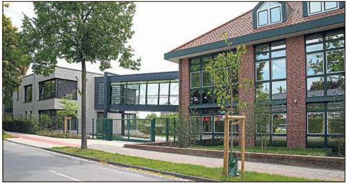
Eine gläserne Brücke verbindet den Neubau der Stadtwerke Ostmünsterland an der Westkirchener Straße in Ennigerloh mit dem bestehenden Verwaltungsgebäude. Foto: dis
