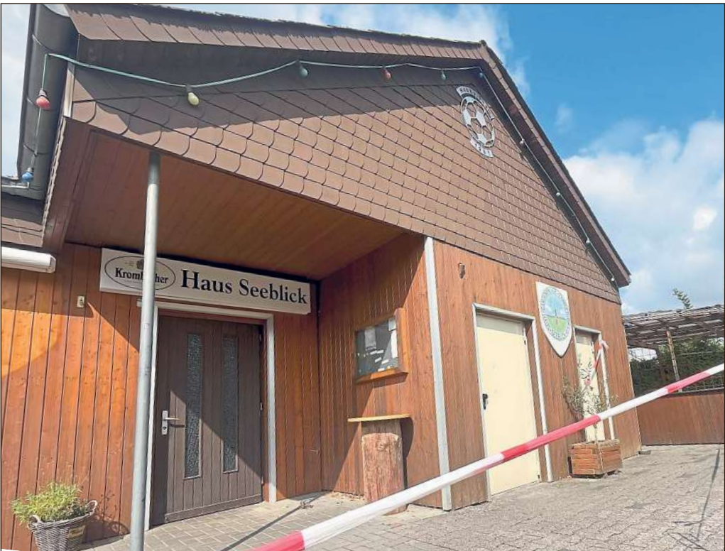
Die Schäden im Haus Seeblick des Kleingartenvereins Ennigerloh sind so gravierend, dass es bis auf Weiteres aus Sicherheitsgründen geschlossen bleiben muss. Foto: T. Junker
