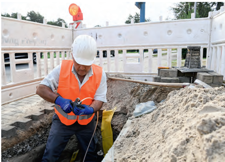
Der Glasfaserausbau in Gütersloh schreitet zügig voran – für jeden an den Bauarbeiten erkennbar.
