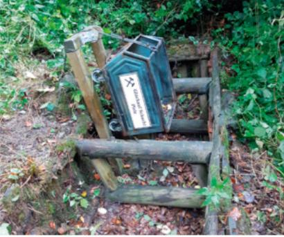
dem mittleren Förderfeld und dem rechten Fahrfeld mit der Leiter „Fahrte“ mit Kappe, Stützen und Stempeln die gegen die Schubkräfte miteinander verbolzt wurden. Ein Schild erläutert noch weitere Details.
