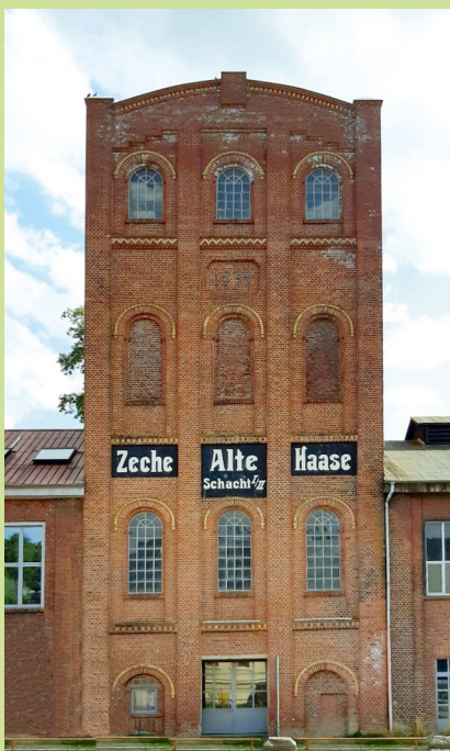
(01) Malakowturm der Zeche Alte-Haase
