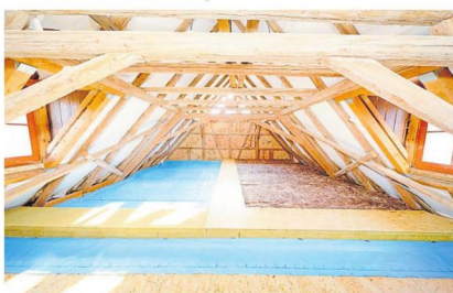
Der Dachboden lässt sich mit nur wenig Aufwand effizient dämmen. Heimwerker können dies mit Glas- oder Steinwolle im Do-it-yourself-Verfahren umsetzen.
