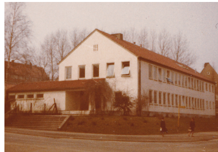
Abb. 4: SVUA in der Berliner Allee vor der Erweiterung (ca. 1970)
