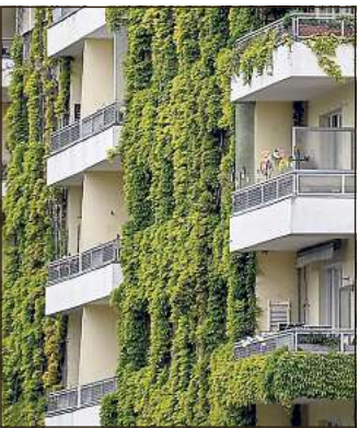
Pflanzen an der Fassade sorgen im Sommer für Schatten und im Winter für zusätzliche Dämmung. Foto: Britta Pedersen/dpa-Zentralbild/dpa-mag
