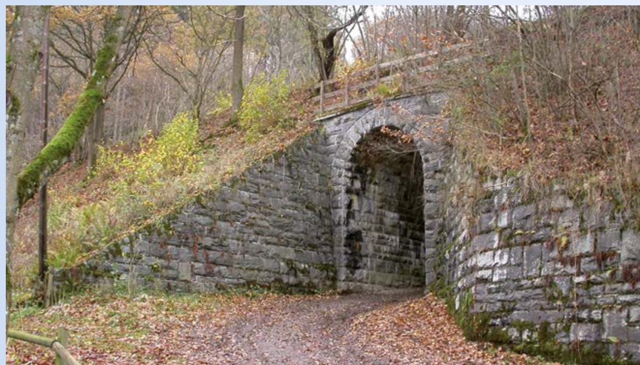
Bahnunterführung der ehem. Bahnstrecke aus Bruchsteinen
