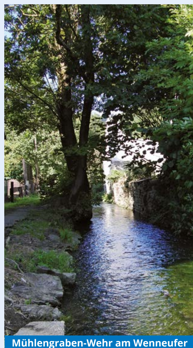
Mühlengraben-Wehr am Wenneufer
