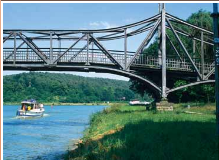
Dortmund-Ems-Kanal in Bergeshövede
