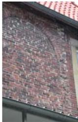
Bei der Abtei handelt es sich um einen Massivbau aus Backstein mit zwei Geschossen, Keller und einem Dachboden, der über eine Dachgaube mittels einer Seilwinde beschickt werden kann. Ein über beide Stockwerke verlaufender Anbau an der Ostseite ist entfernt worden. Der Zeitpunkt des Abbruchs ist nicht bekannt. Auch seine Funktion ist bisher nicht bestimmt werden. Um eine über beide Stockwerke verlaufende Toilettenanlage kann es sich wohl nicht gehandelt haben (Zur
