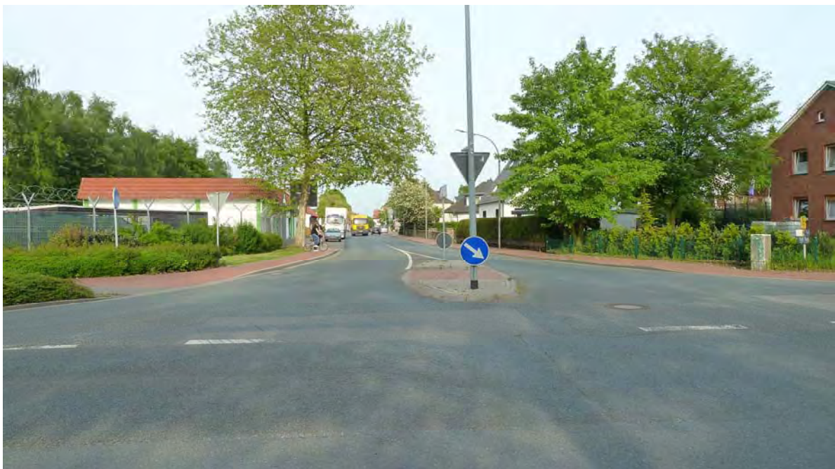
Foto 6: L 595 (Heerstr.) / L 584 (Alte Poststr.), Blickrichtung Osten
