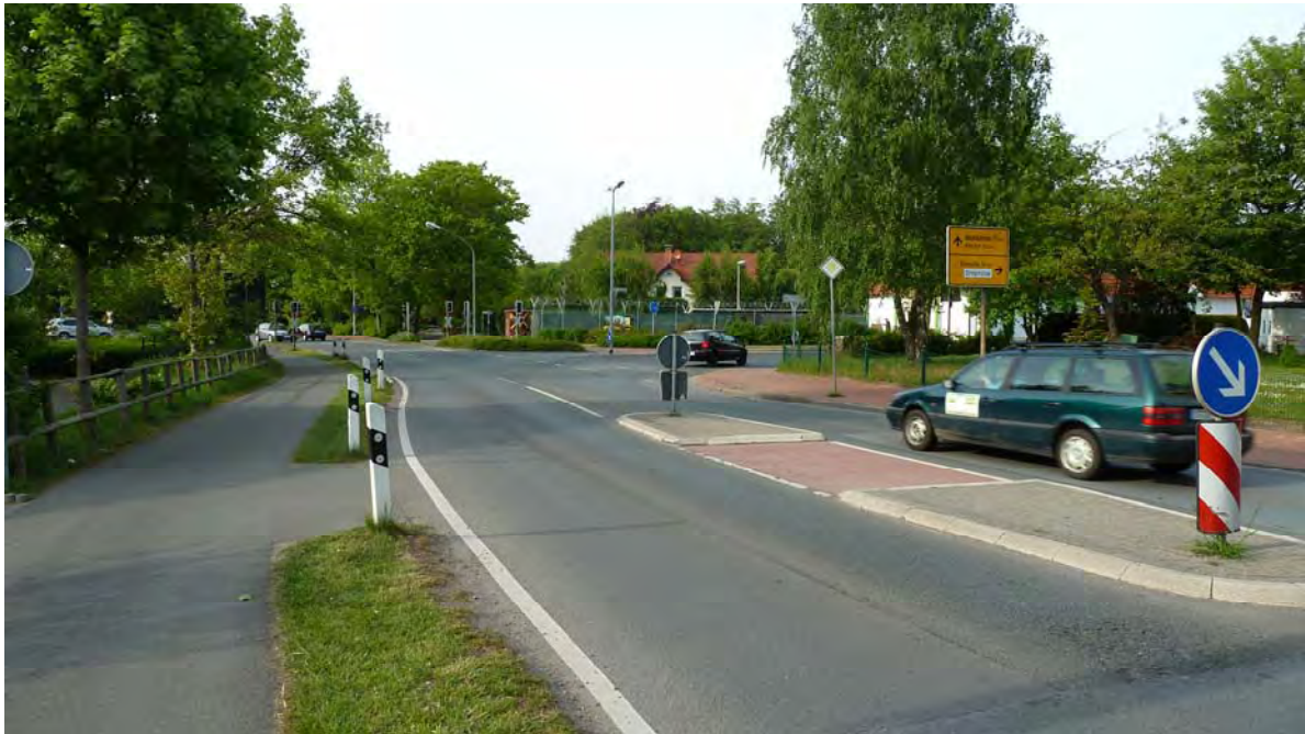
Foto 5: L 595 (Heerstr.) / L 584 (Alte Poststr.), Blickrichtung Norden
