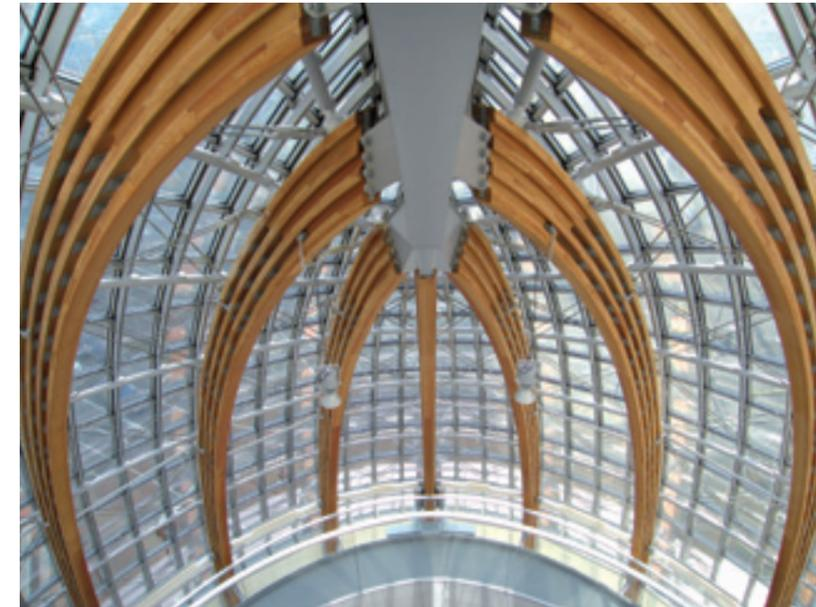
Eine städtebaulich ausgesprochen gute Lösung stellt der Neubau eines Bekleidungs-filialisten in Köln dar: Die geschuppte Glasfassade des organisch geformten Ostflügels wird von einer selbsttragenden Holzrippenschale aus 66 Lamellenböden aus Lärche getragen. Die Konstruktion wurde mit dem 1. Holzbaupreis Nordrhein-Westfalen 2006 ausgezeichnet.
