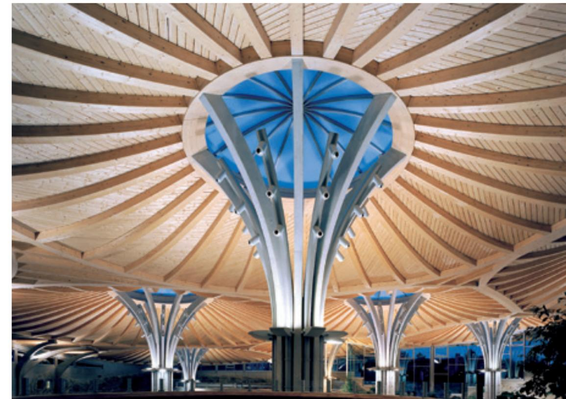
Im Elefantenpark des Zoologischen Gartens in Köln tragen die baumartigen Stützen des Elefantenhauses eine geschwungene Dachkonstruktion mit Spannweiten von über 20 Metern.
