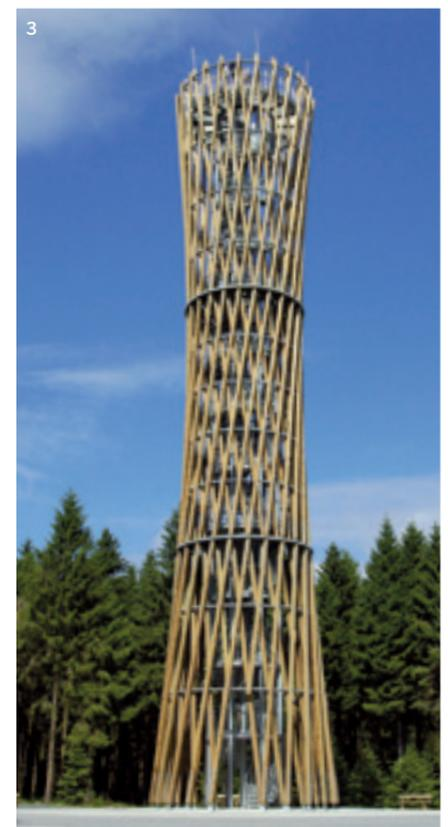
3 Der 35 m hohe Lörmecke-Turm befindet sich im Naturpark Arnberger Wald. Die offene Turmkonstruktion besteht aus 144 Douglasienstämmen mit Längen von 10,60 m bis 13,80 m.
