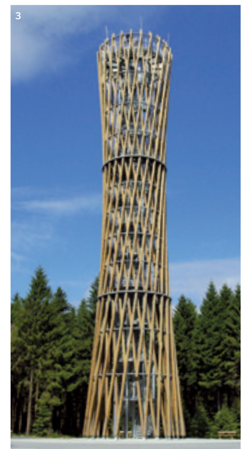
3 Der 35 m hohe Lörmecke-Turm befindet sich im Naturpark Arnsberger Wald. Die offene Turmkonstruktion besteht in ihren statischen Elementen aus 144 über Kreuz geführten bzw. über- und nebeneinander angeordneten Douglasienstämmen mit Längen von 10,60 m bis 13,80 m.
