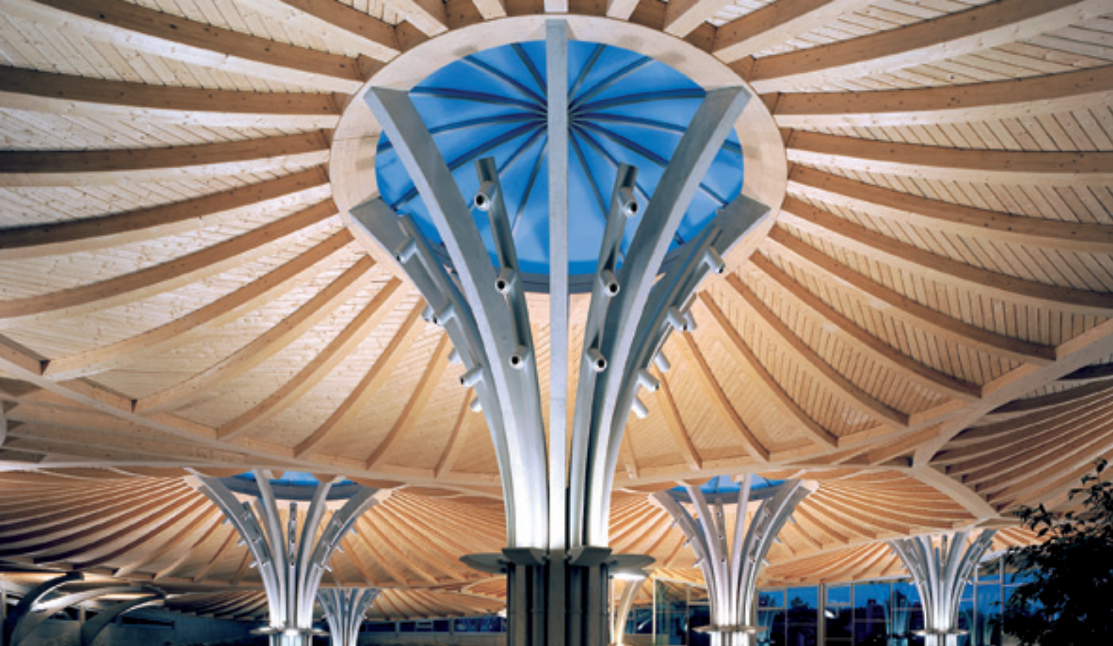
Im Elefantenpark des Zoologischen Gartens in Köln tragen die baumartigen Stützen des Elefantenhauses eine geschwungene Dachkonstruktion mit Spannweiten von über 20 Metern.
