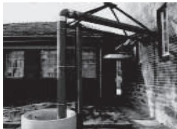
den Außengelände geleitet wird. Dort fließt das Wasser erst in einen Teich, um dann in Mulden zu versickern. Hierdurch werden 7 000 qm versiegelte Fläche abgekoppelt.
