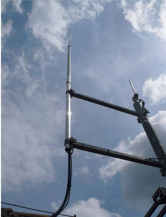
**Abb . 1:** Omnidirektionale Senderantenne
