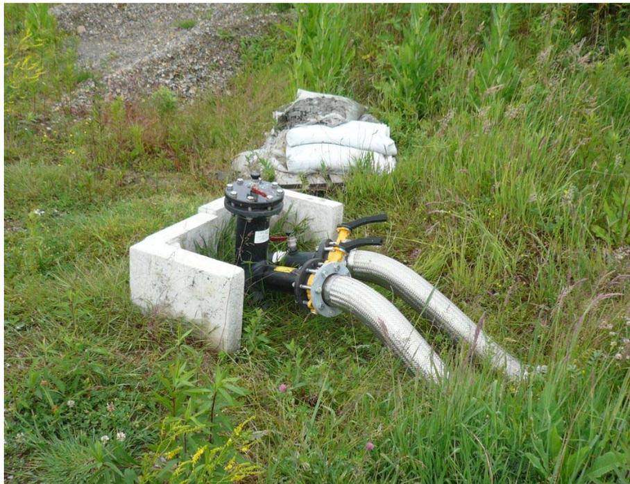
**Abbildung 16** Gasbrunnen für eine Aerobisierungsmaßnahme
