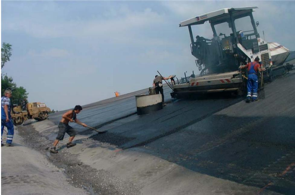
**Abbildung 10** Einbau von Deponieasphalt mit einem Fertiger
