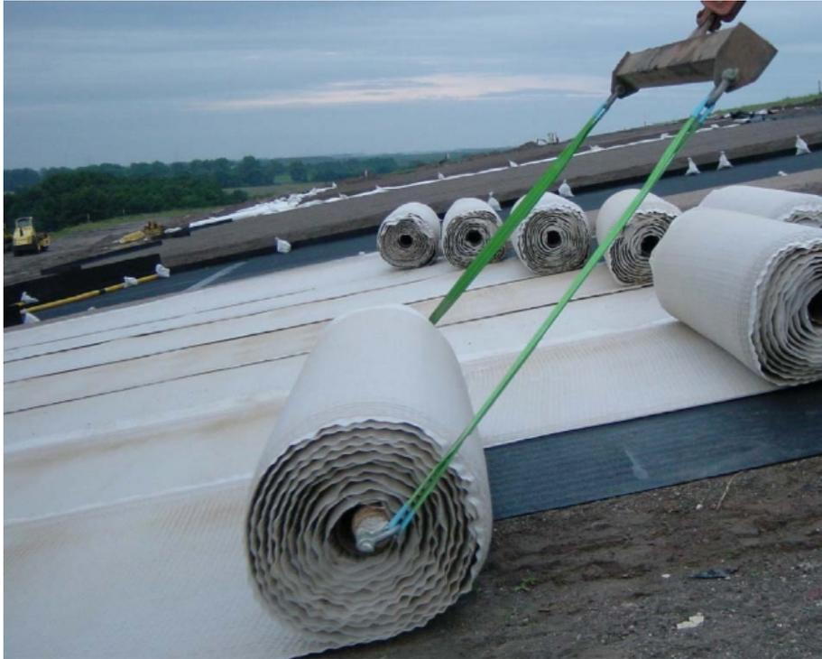
**Abbildung 8** Verlegung einer Kapilllarblockbahn (KBB)
