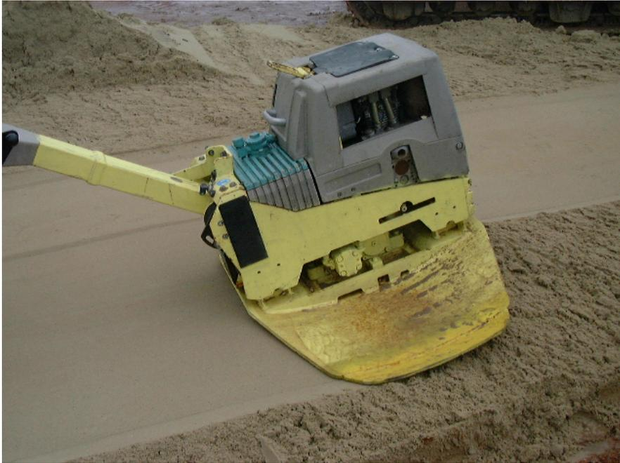
**Abbildung 9** Verdichtung einer TRISOPLAST-Dichtungsschicht
