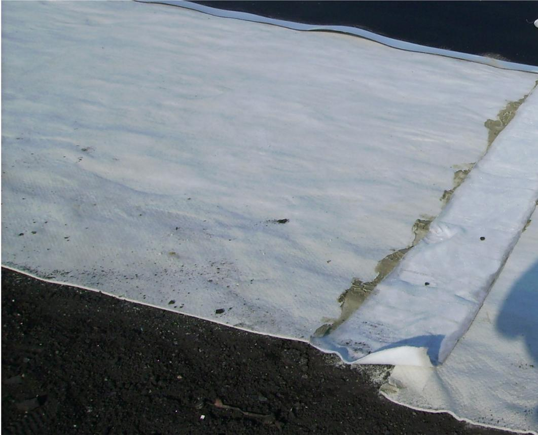
**Abbildung 7** geosynthetische Tondichtungsbahn
