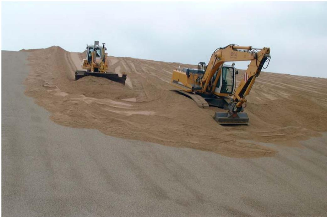
**Abbildung 13** Einbau einer Kapillarsperre
