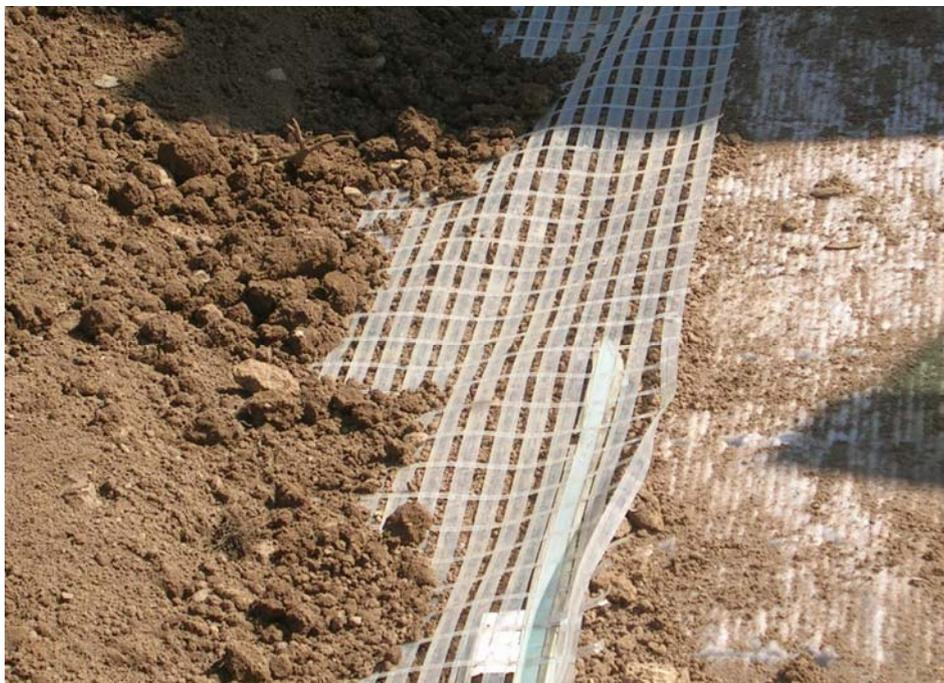
**Abbildung 4** gelegtes Geogitter in einer steilen Böschung
