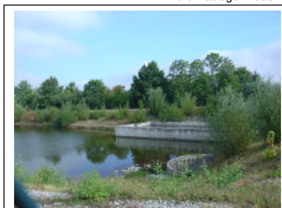
Abb. 14: Regenrückhaltebecken im GG Soest Südost
