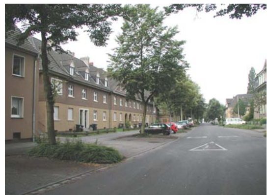
Abb. 45: Geschlossene Blockrandbebauung (Zechensiedlung Lohberg) mit alleeartiger Straßenbepflanzung und kleinen Vorgärten
