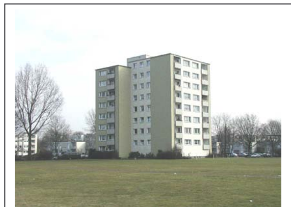
Abb. 47: Hochhaus (Bassfeldhof) mit großflächigem, wenig strukturierten Rasenflächen
