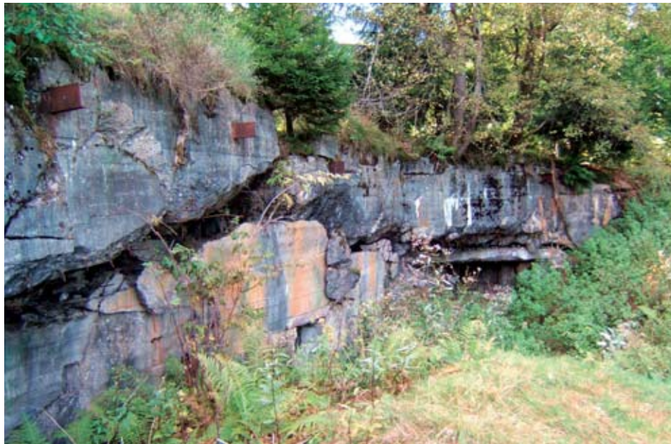
Ein teilweise zerstörter Bunker. Die Sprengkraft reichte nicht aus, um die Decke komplett zu zerstören. Der vordere Bereich bietet noch Wind- und Wetterschutz, während die Anlage hinten nach oben hin offen ist.
