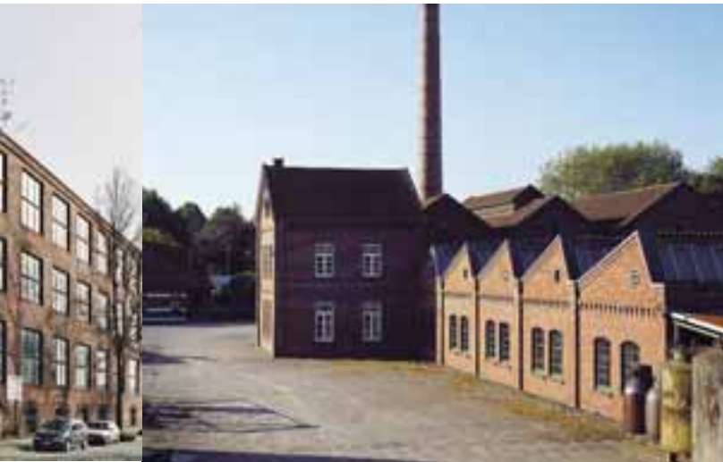
Die historische Spinnerei Herding (li.) liegt unweit der jetzigen Museumsfabrik (re.) mit ihren typischen Sheddächern
