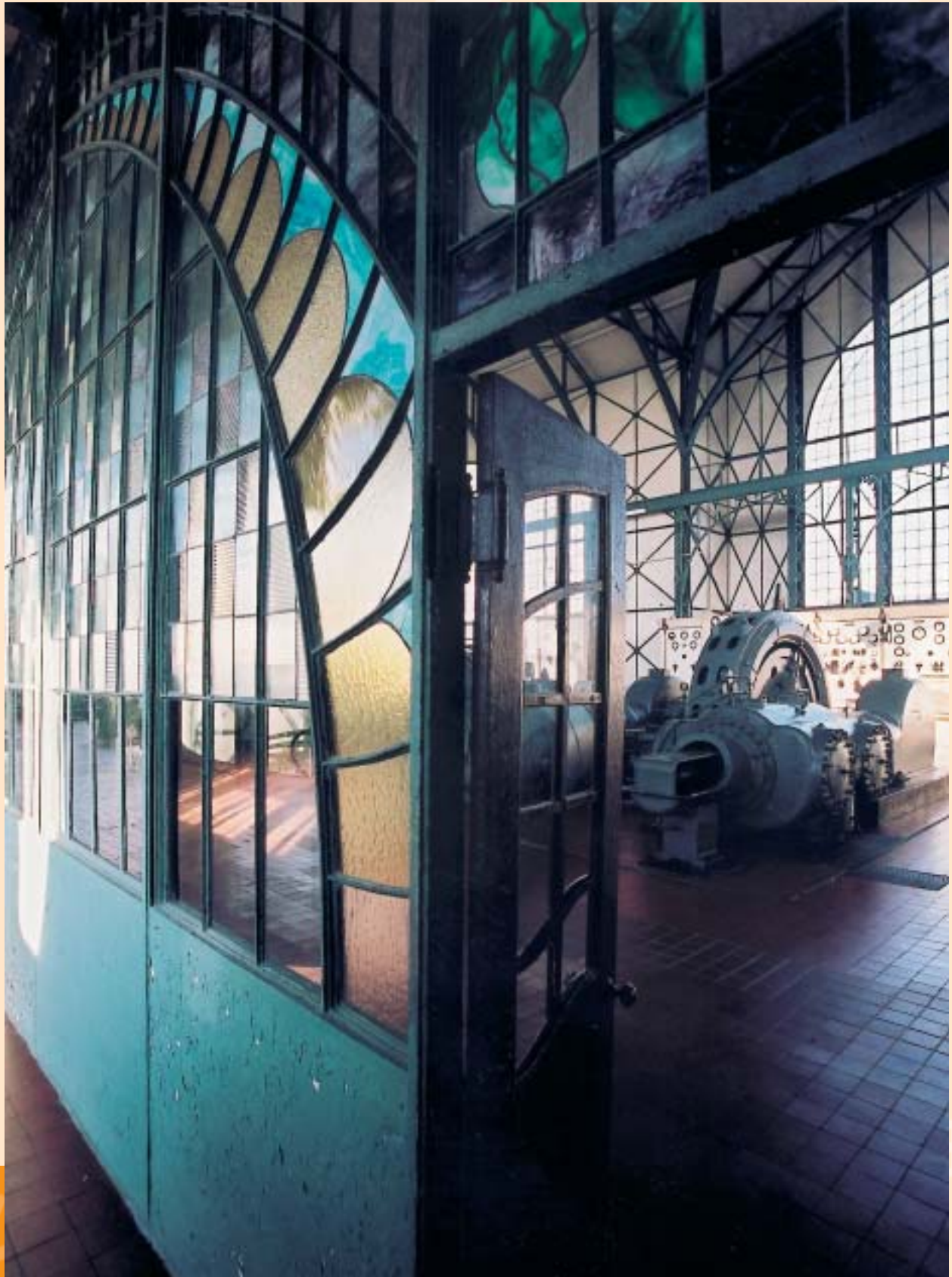
Blick in die Maschinenhalle der Zeche Zollern II/IV mit ihrer markanten Stahlkonstruktion
