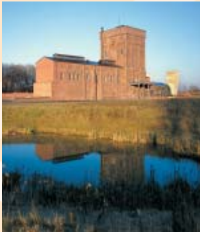
Malakowturm und Maschinenhaus sind Wahrzeichen der Zeche Hannover in Bochum
