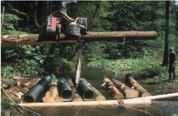
Abbildung 3: Bei Forstarbeiten werden PED-Rohre zum Überqueren von Bachläufen verwendet, um Uferschäden zu vermeiden.
