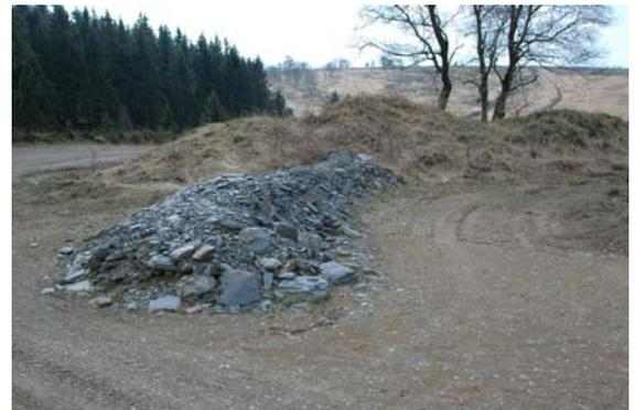
*Abbildung 6: Sedimentsperre auf dem Truppenübungsplatz Elsenborn (Belgien). Bevor der mit Feinsediment belastete Oberflächenabfluss in ein Fließgewässer gelangt, wird er seitlich umgelenkt. Die Feinsedimente setzen sich ab. Das Wasser versickert.*
