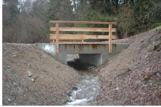
Abbildung 5: Haubenprofil mit Niedrigwasserprofil im Bauwerk kurz nach der Fertigstellung.
