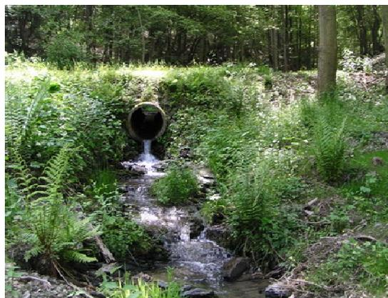
Abbildung 5: Verrohrung = Unterbrechung des Fischwechsels
