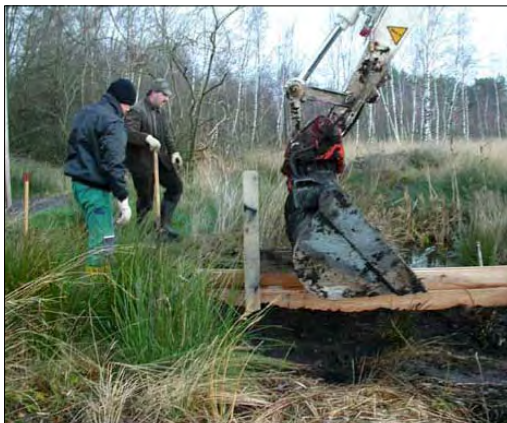
Abb. 5: Bau von Dämmen und Stauanlagen. Das Foto oben vom April 2005 zeigt die Wiedervernässungsmaßnahmen. Das Wasser wird in den Poldern gehalten.
