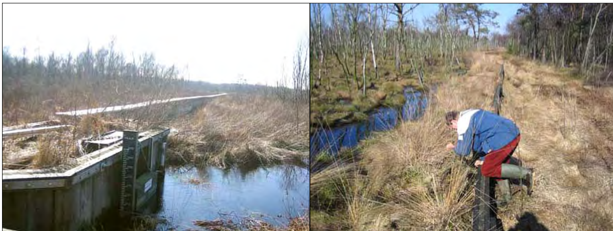
Abb.6: Der Wasserstand in den Poldern wird mittels Überläufen reguliert.
