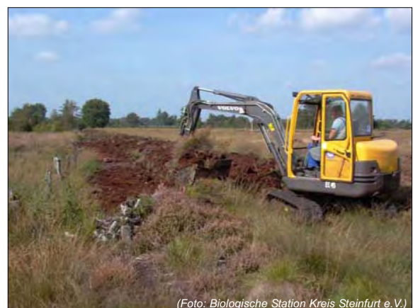
Errichtung eines Torfdammes
