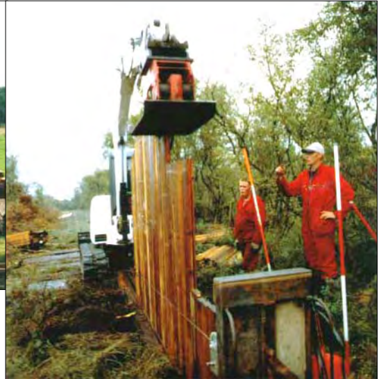
Abb.5: Die Bohlen für die Spundwand wurden mit dem Hubschrauber ins Gebiet geflogen und anschließend mit einem Hydraulikbagger in den Boden gedrückt.
