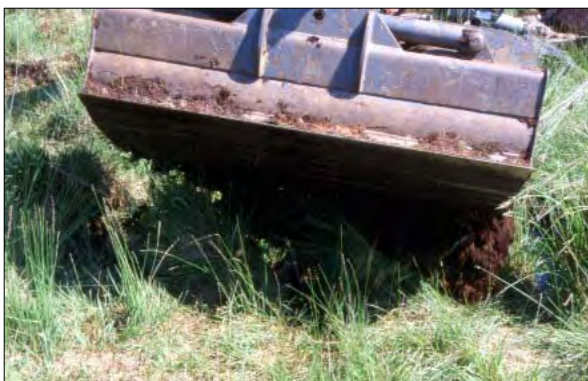
Abb 4: Kleine Entwässerungsgräben wurden mit Kunststoffplatten aus Polyethylen verschlossen. Der Bagger drückte die Platten in den Torf, nachdem mit der Motorsäge ein schmaler Schlitz in den Torf geschnitten wurde.
