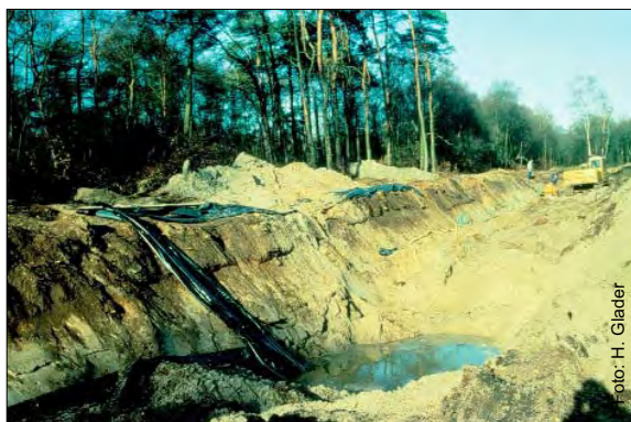
Abb. 13: Burlo-Vardingholter Venn, Kr. Borken, Einbau einer abdichtenden Folie
