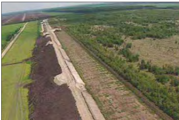
Abb. 3: Im Rahmen des LIFE-Projektes wurden 10 km Dämme gebaut.
