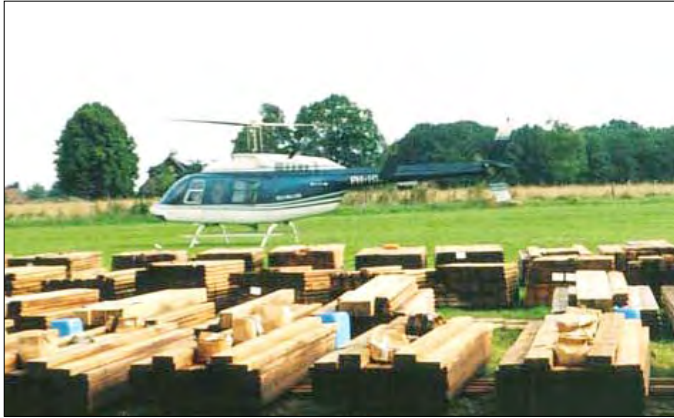
Abb.5: Die Bohlen für die Spundwand wurden mit dem Hubschrauber ins Gebiet geflogen und anschließend mit einem Hydraulikbagger in den Boden gedrückt.
