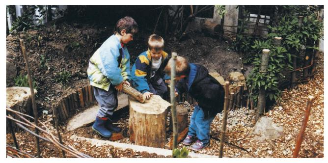
Ist eine Nutzung als offene Sprung- oder Arbeitsgrube vorgesehen, bietet es sich an, den Grubenrand durch unbehandelte Rundhölzer zu verstärken. Diese mit dem Erdreich abschließende "Palisadenmauer" verhindert das Einbrechen und Abtragen des Grubenrandes. Die Rundhölzer sollten 20 bis 30 cm tief eingesetzt werden.
