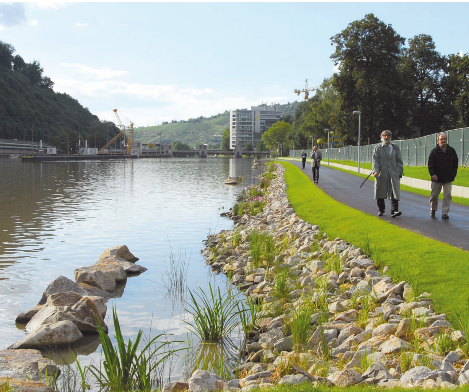
Saniertes und zu bewertendes Teilstück des Neckartalradwegs in Esslingen a. N.
